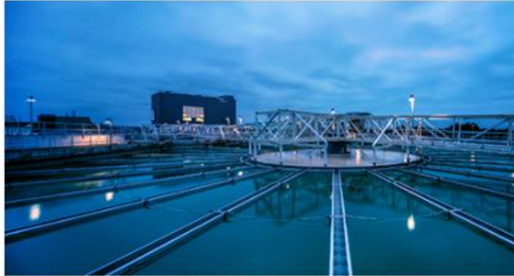
277 Atık Su Arıtma Tesisi Sürekli Atık Su İzleme Sistemi (SAİS)
